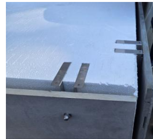
EPSブロックの施工面
